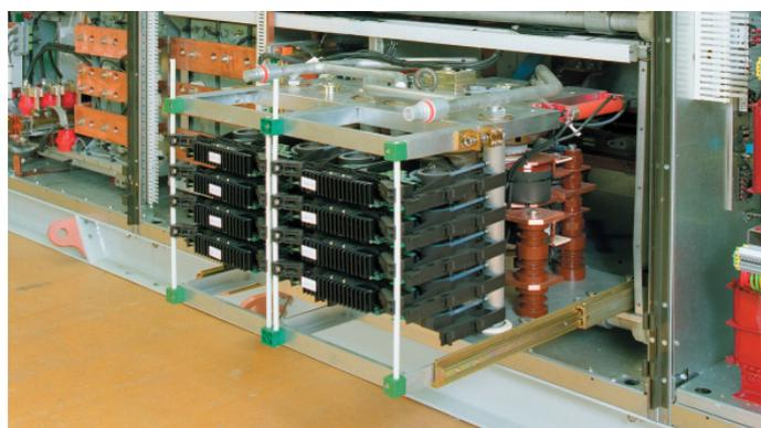
Фазные модули инвертора привода ACS 5000 с водяным охлаждением монтируются на выдвижных направляющих.
